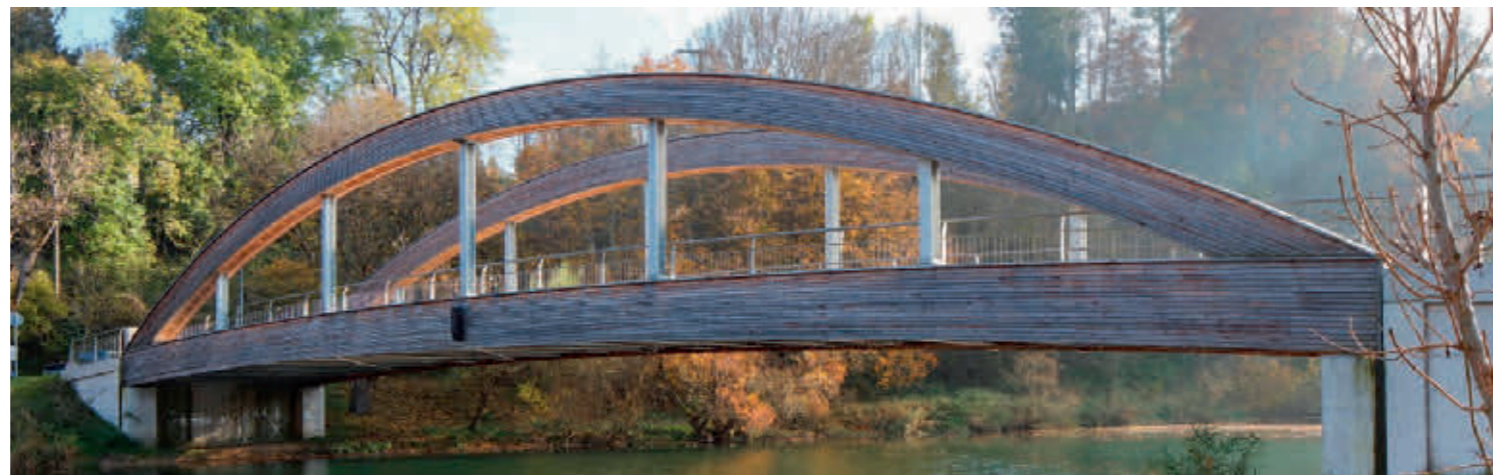
Holzbogenbrücke Naturpark Obere Donau
