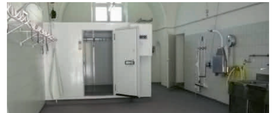
Neubau Wildkammer Altshausen
